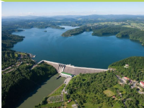
Elektrownia Wodna Solina Moc zainstalowana: 198,66 MW Typ: Szczytowo-pompowa
